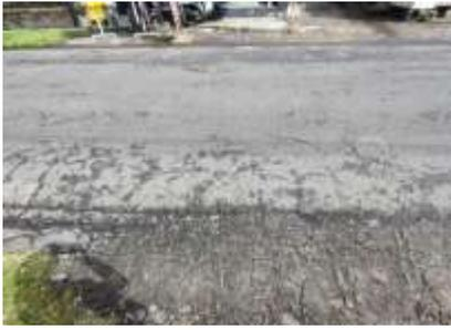
Gambar 5. Retak Sambungan
