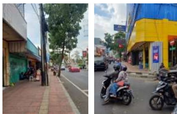
Gambar 2. Kondisi Trotoar pada Kawasan Pusat Perbelanjaan
