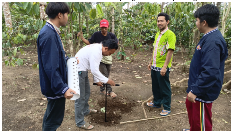
Gambar 5. Dokumentasi kegiatan pendampingan instalasi LRB
