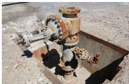
Gambar 9. Kepala sumur dari sumur H-43 yang ditinggalkan di lapangan geothermal Los Humeros [5].
