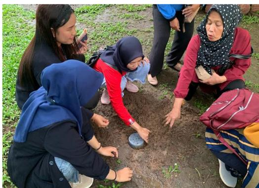
Gambar 6. Tim bersama kader menutup celah yang ada di sekitar lubang biopori untuk langkah *finishing*
