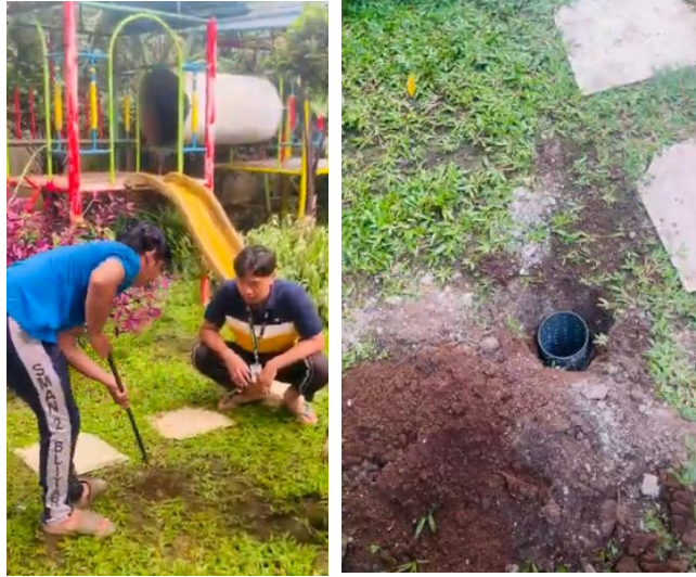
Gambar 1. (a) Tim melakukan penggalian tanah sesuai titik yang telah ditentukan, (b) Penyesuaian lubang galian yang telah dibuat dengan sampel pipa paralon. Sumber: Dok Pribadi, 2024
